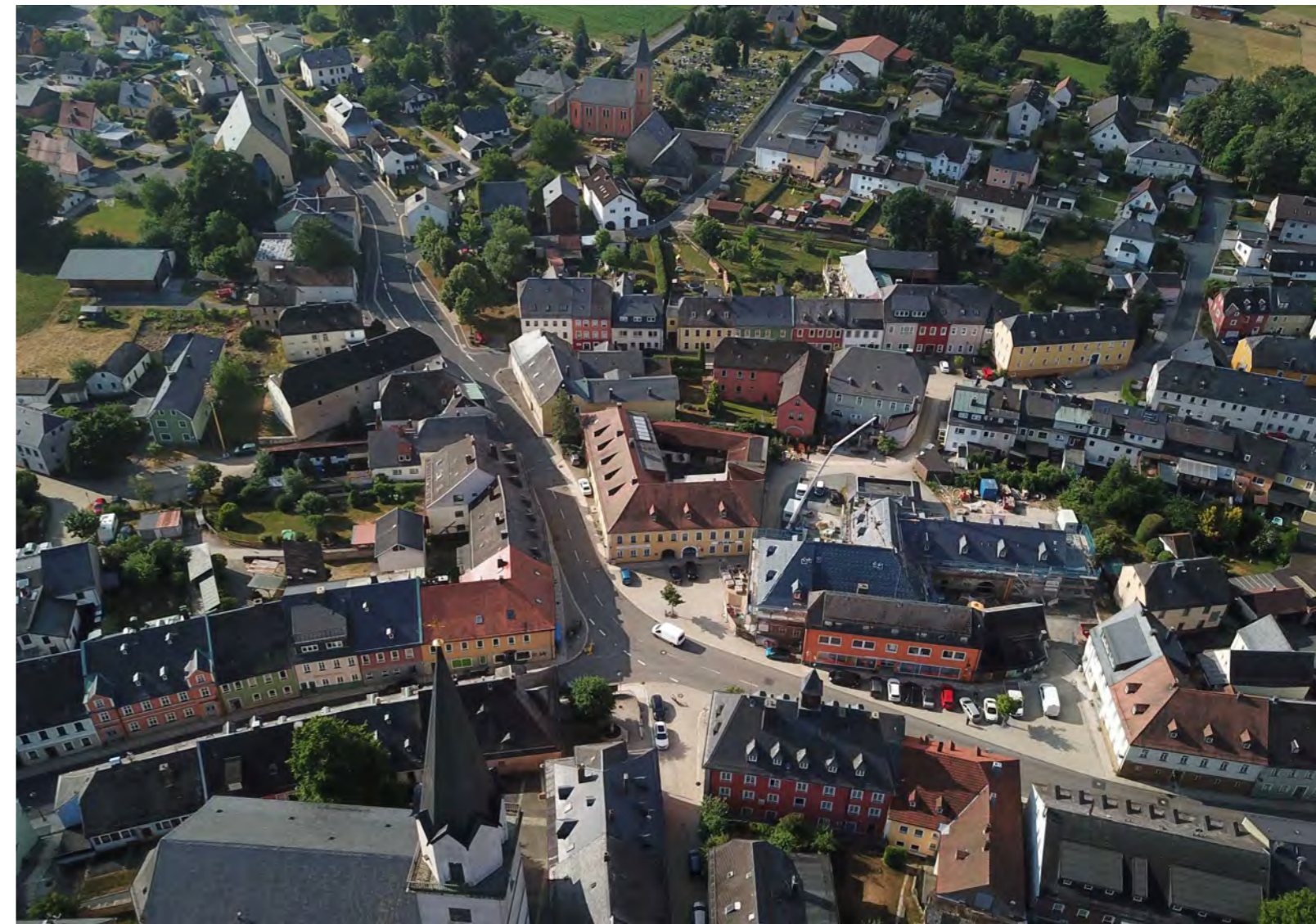
Abb. 24 | Blick auf das Untersuchungsgebiet im Bereich Marktplatz
