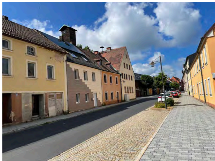
Abb. 16 | li.: Typische Zeilenbebauung im Stadtkern, äußere Weißenstädter Straße
